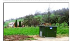
► Gevresin. Dernièrement, le poste de transformation électrique "cabinet haute" a été remplacé par un nouveau poste de distribution publique électrifié beaucoup plus discret, au vu de l'état, très dégradé, de l'ancien transformateur et sur sollicitation du maire. ERDF a réalisé une étude de vitesse qui a confirmé la nécessité de faire tomber l'ouvrage. Les travaux ont été réalisés par l'entreprise Vigilec et par ERDF pour les travaux sous tension. Cette opération a également permis d'enterrer une partie du réseau à proximité du transformateur électrique. Ces travaux, d'un montant de 39.000 € ont été financés par ERDF.
